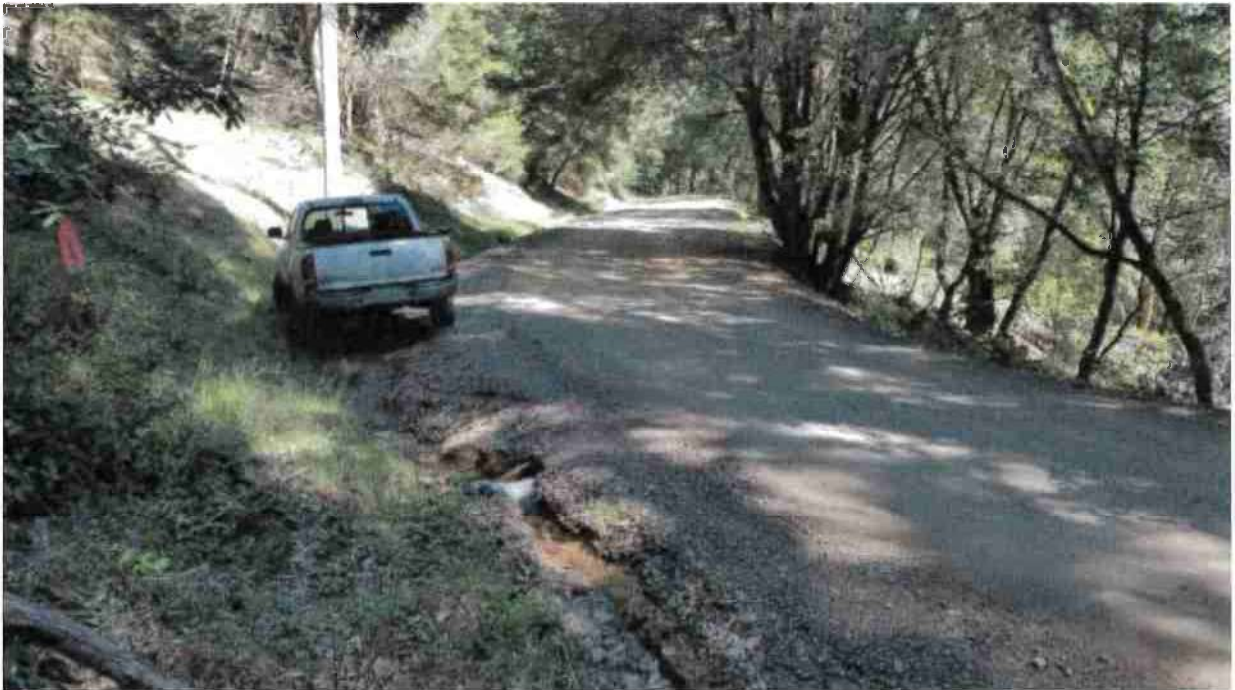
Ditch Relief Culvert 1
