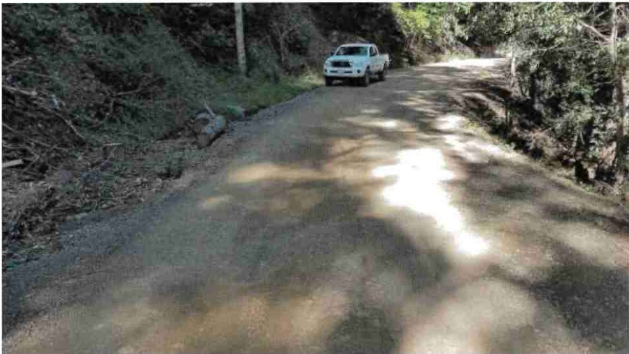
Ditch Relief Culvert 2
