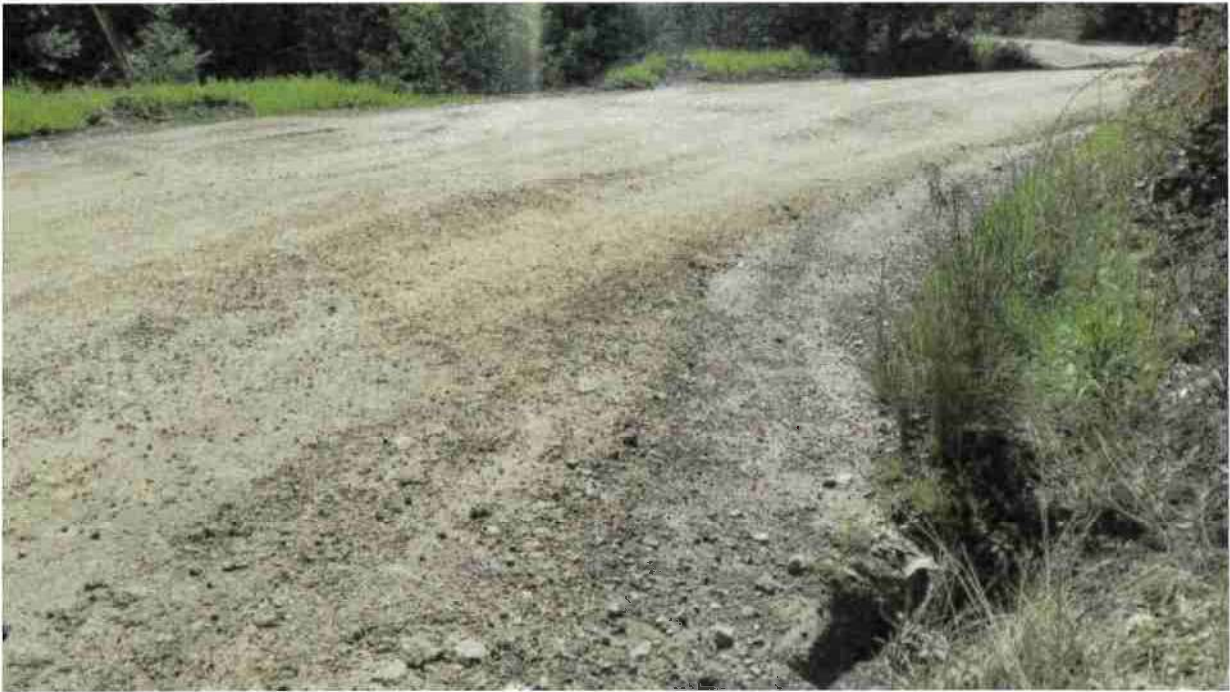
Ditch Relief Culvert 3
